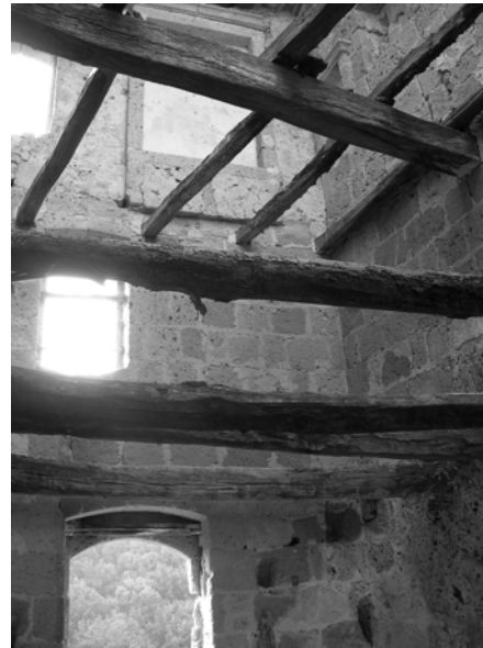
fig. 3 stato di fatto: i solai intermedi
