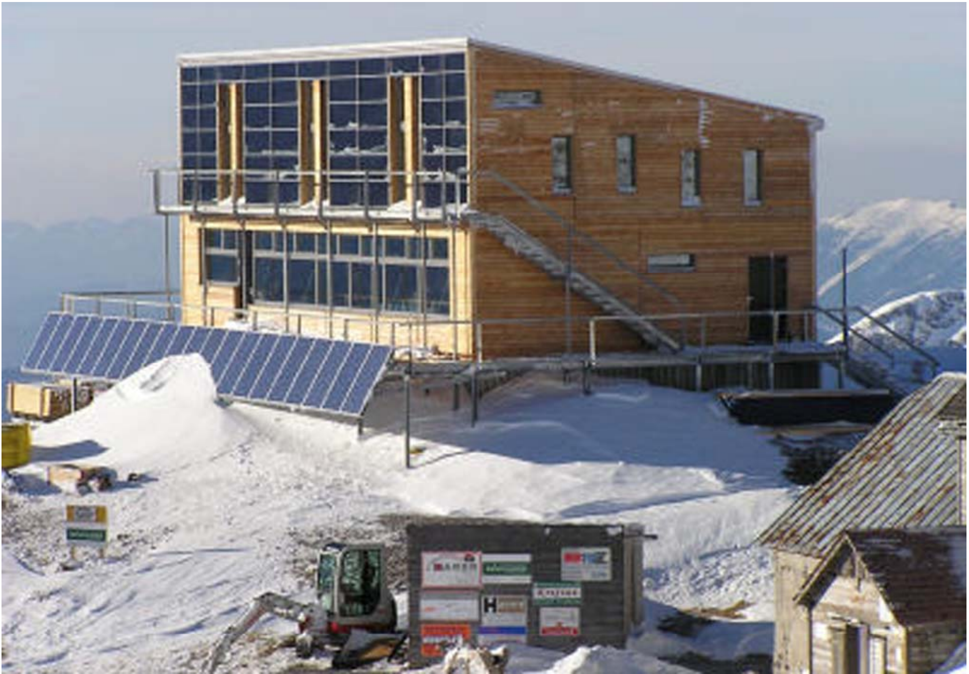
Casa Passiva - Rifugio Schiestlhaus a 2150m slm - Austria
