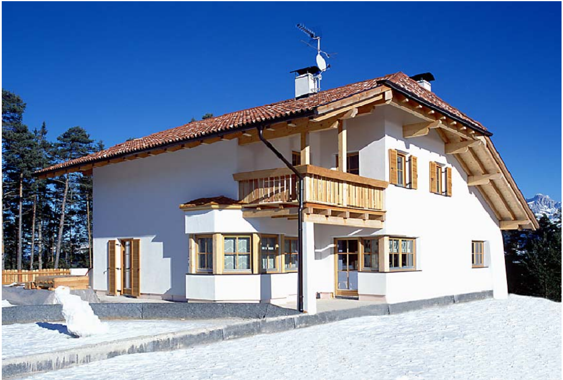
Casa privata (BZ) -Prog.: Geom.Plank
