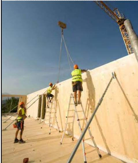
Cese di Preturo 11 luglio 2009 Montaggio pannelli piano terra
