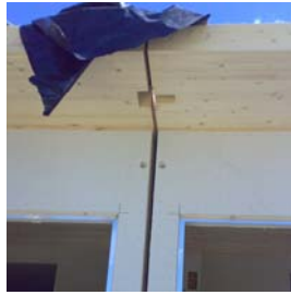
Verankerung Holzriegelwand Fissaggio parete in legno a traliccio
