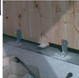
Verankerung Holzriegelwand Fissaggio parete in legno a traliccio
