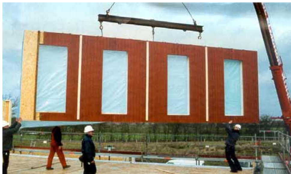
Esempio di elementi a struttura intelaiata
