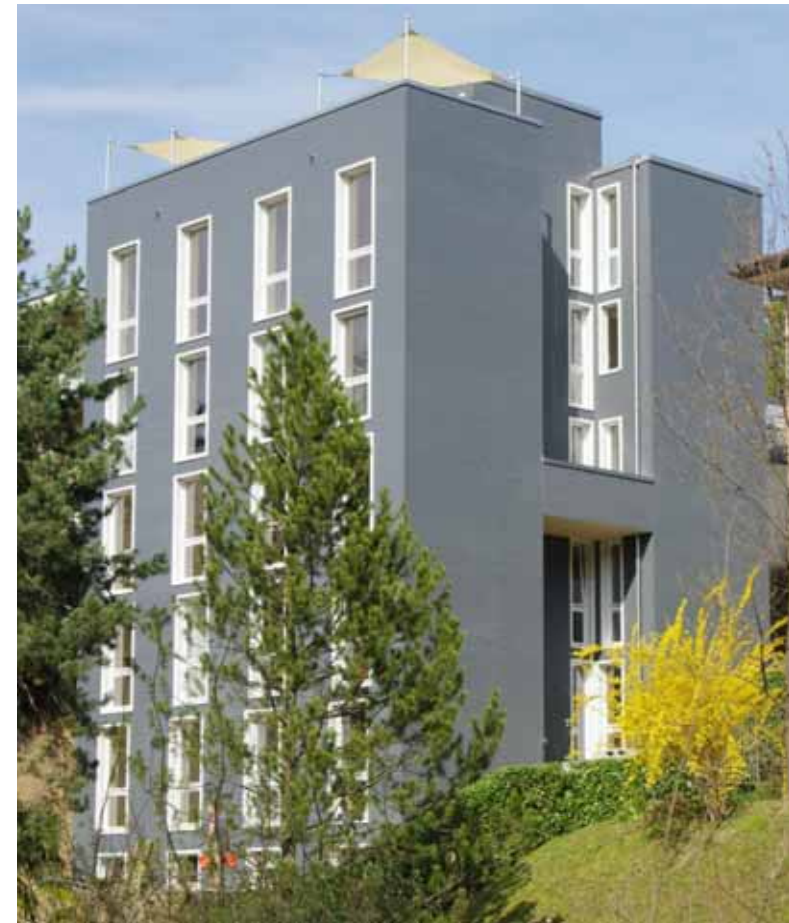
Convegno - Edifici di legno Materiali e sistemi all'avanguardia - 5
