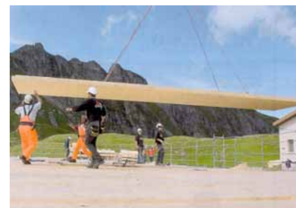
Convegno - Edifici di legno Materiali e sistemi all'avanguardia - 64
