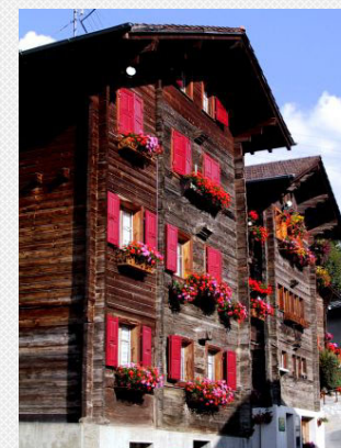
Convegno - Costruire in sicurezza in zona sismica La costruzione in legno in zona sismica - 13
