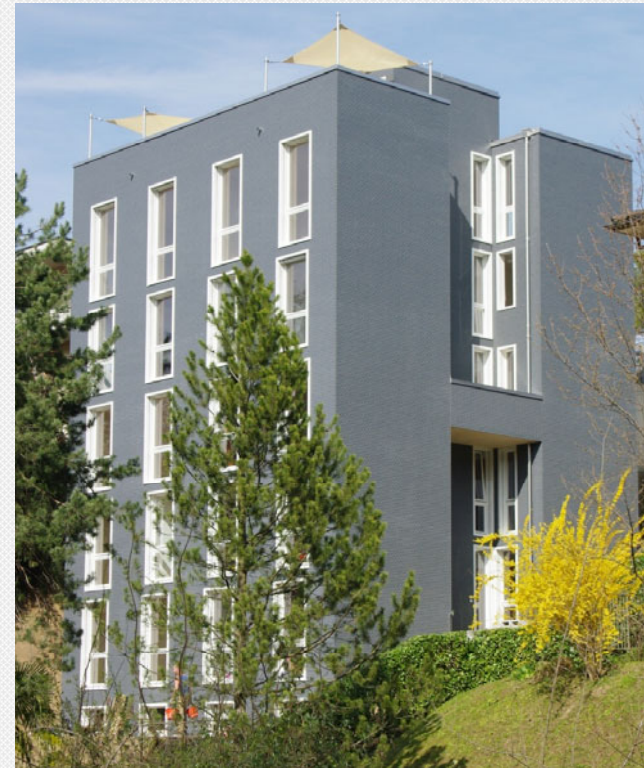
Convegno - Costruire in sicurezza in zona sismica La costruzione in legno in zona sismica - 15
