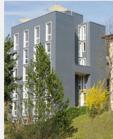
Convegno - Costruire in sicurezza in zona sismica La costruzione in legno in zona sismica - 33
