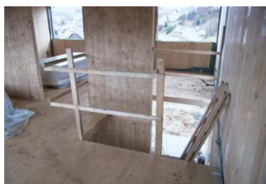
Apertura nel solaio per il passaggio della scala
