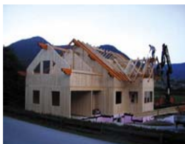
Abitazione unifamiliare – Wörschach (A)
