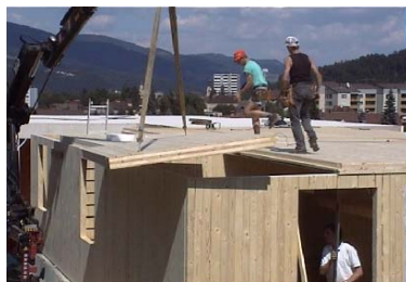
Posa in opera dei solai
