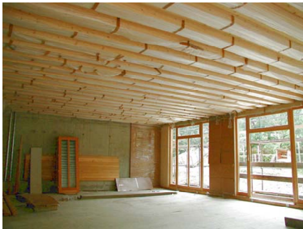
Figura 9: Pannello di compensato di tavole con nervature di lamellare incollato e variante a sezione a cassone
