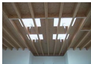
Apertura nel solaio per lucernari
