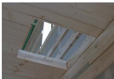
Apertura nel solaio per il passaggio della canna fumaria
