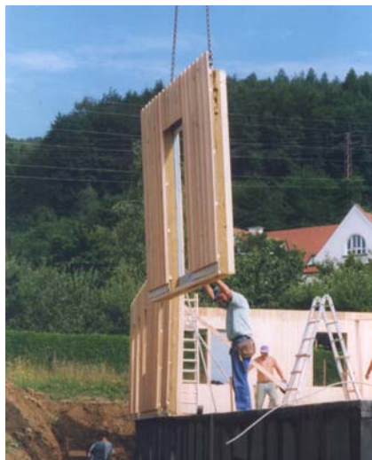
Figura 10: Montaggio di un elemento preassemblato (sin.) e fissaggio di elementi di isolamento e di facciata (des.)
