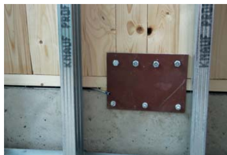
Figura 21: Giunzione parete-fondazione, disposizione di lamiere ed angolari d'acciaio come rinforzo ed ancoraggio per gli sforzi di trazione
