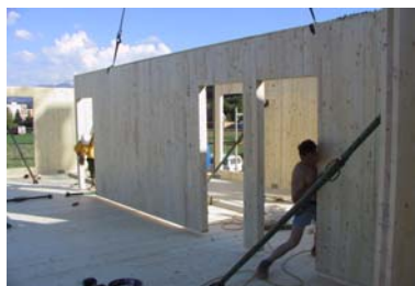
Posa in opera delle pareti
