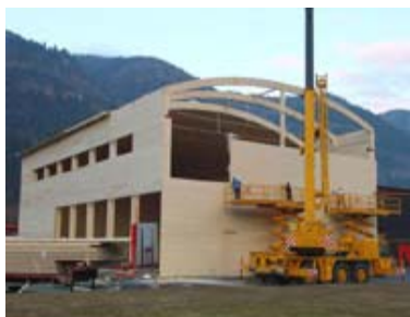
Stabilimento della ditta KLH – Katsch a. d. Mur (A)
