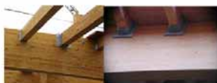
Protezione dei collegamenti a scarpetta mediante lastre di silicato di calcio
