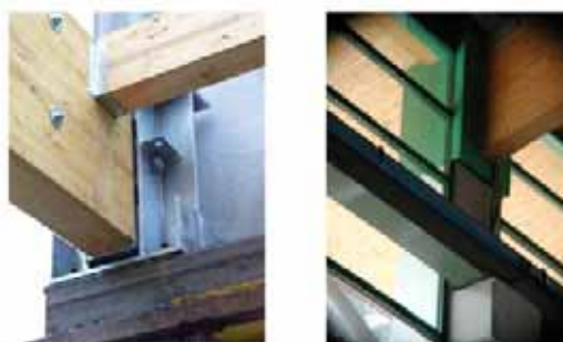
Protezione di una cerniera di estremità con lastre di silicato di calcio
