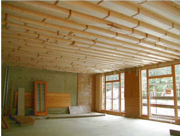
Figura 46: Pannello di legno compensato di tavole con nervature di legno lamellare incollato e variante a sezione a cassone
