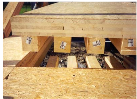
Figura 47: Impiego di un pannello di legno compensato di tavole rinforzato da nervature di lamellare incollato nella costruzione di un ponte
