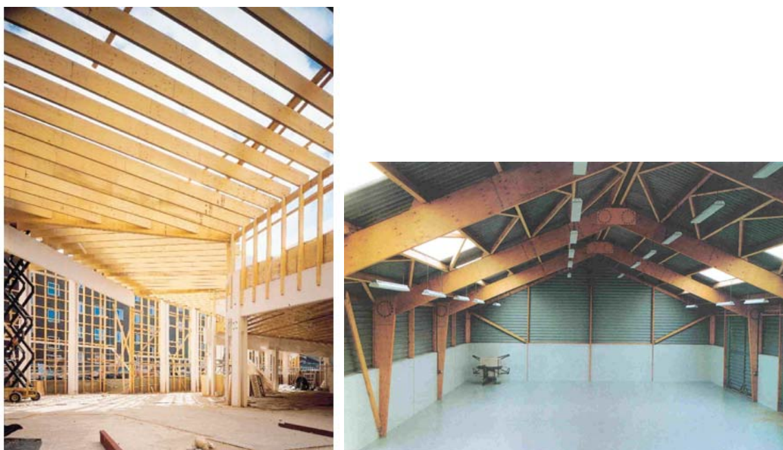
Figura 33: Capriate di legno stratificato: biblioteca di Villila/Finlandia (sin.) e capannone “Sixt-sur-Aff”/Francia
