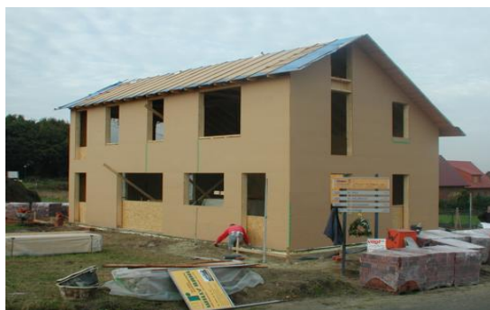
Figura 18: Pannelli MDF traspiranti come rivestimento di elementi di pareti (sin.) e utilizzo di pannelli di fibra di legno (HDF) per il rivestimento esterno dietro la facciata (des.)
