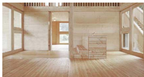
Figura 36: Impiego di pannelli multistrato come elemento di facciata (sin.) o come rivestimento interno (des.)
