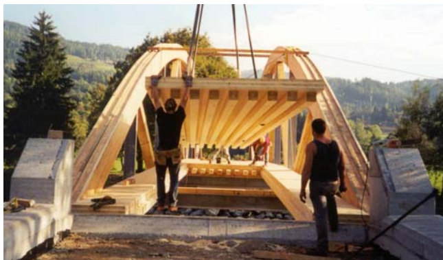
Figura 47: Impiego di un pannello di legno compensato di tavole rinforzato da nervature di lamellare incollato nella costruzione di un ponte
