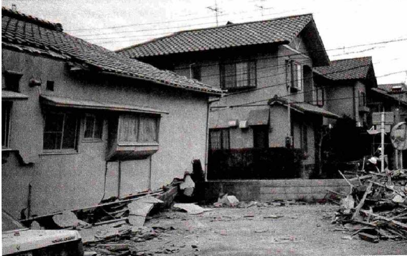
Case in legno (timber-frame) moderne non danneggiate, e casa vecchia crollata (Nishinomiya, Japan)
