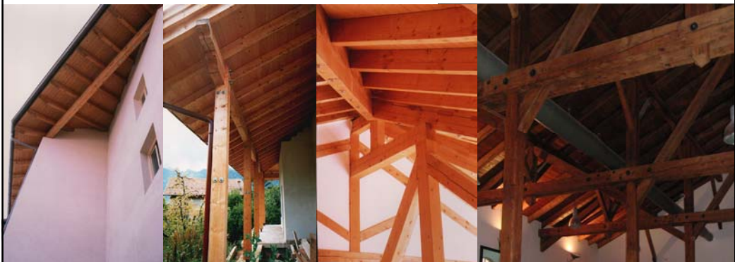
Coperture in legno di abitazioni civili
