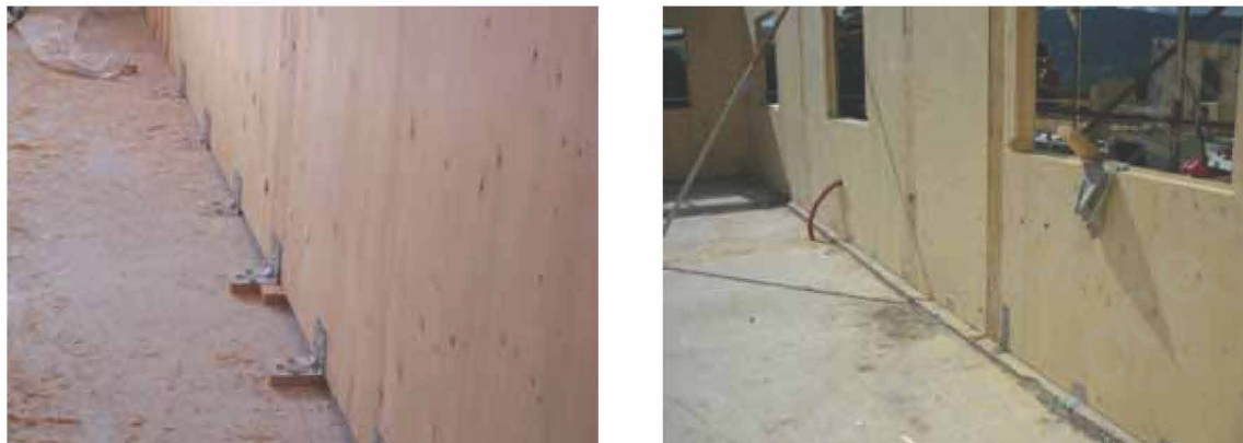
Figura 4 Soluzione 1 e 2 del nodo di fondazione (courtesy of STP srl)
