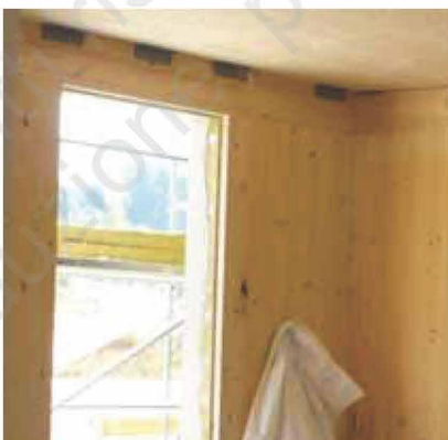
Figura 8 Sistemi di trasmissione degli sforzi di taglio tra parete e solaio (progetto C.A.S.E. L'Aquila 2009)
