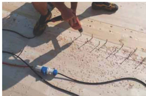
Figura 8 Sistemi di trasmissione degli sforzi di taglio tra parete e solaio (progetto C.A.S.E. L'Aquila 2009)
