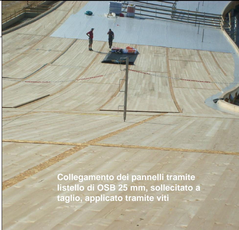
Collegamento dei pannelli tramite listello di OSB 25 mm, sollecitato a taglio, applicato tramite viti
