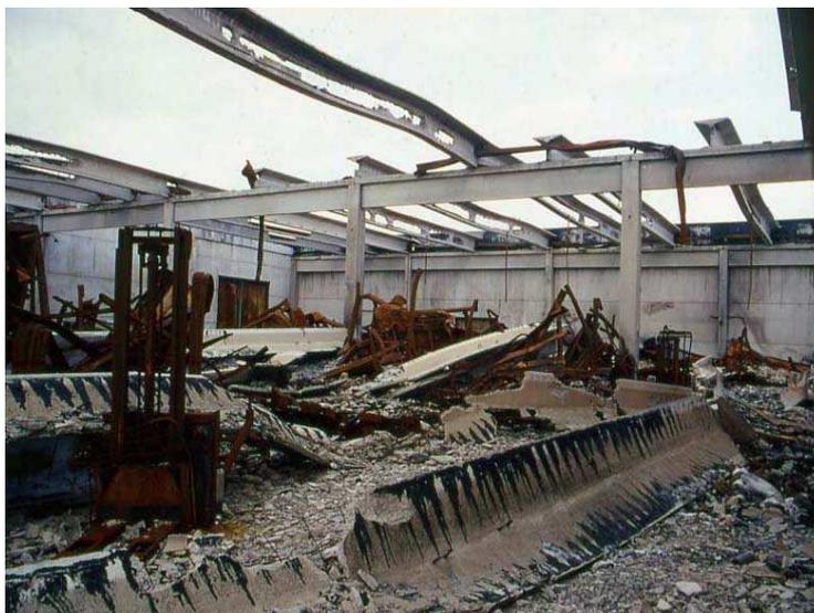
Figura 3: Capannone di cemento armato completamente distrutto a seguito di un incendio; le armature metalliche perdono resistenza e rigidità con l'aumento della temperatura, provocando rapidamente il crollo della struttura.
