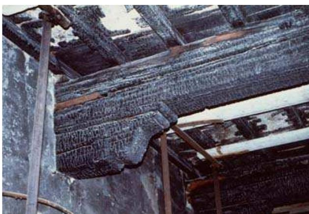
Figura 1: Solaio di legno non crollato a seguito di un incendio.
