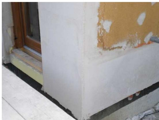
*Figura 10: L'edificio, realizzato con struttura a pannelli di legno massiccio a strati incrociati, è rivestito con pannelli di fibra di legno aderenti alla struttura; il successivo strato di intonaco rende la superficie non infiammabile e impedisce la propagazione del fuoco in facciata*
