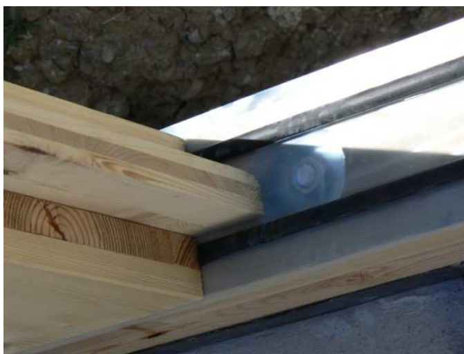
Figura 4: Posizionamento di uno strato di gomma al contatto fra parete e cordolo.
