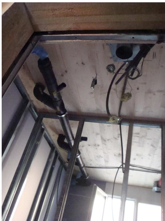
Tutte le forometrie devono essere pianificate ed effettuate già in fase di prefabbricazione, per evitare errori durante l'esecuzione, ritardi nell'esecuzione, disagi per l'esecuzione e maggiorazione dei costi. Il montaggio degli impianti procede con l'avanzare della costruzione.
