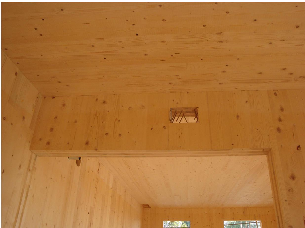
I collegamenti tra i pannelli viene effettuato tramite viti incrociate o piastre metalliche, si capisce bene che effettuare delle forometrie a quote prossime a tali elementi diventa quasi impossibile una volta effettuata la posa, inoltre creerebbe ritardi nelle lavorazioni delle maestranze che durante la posa degli impianti non troverebbero già pronte le vie di posa.
