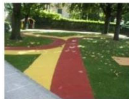
Fig.6 Pavimentazione in gornite colate
