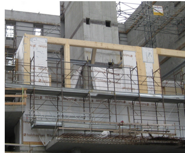
Struttura intelaiata travi e pilastri in legno lamellare
