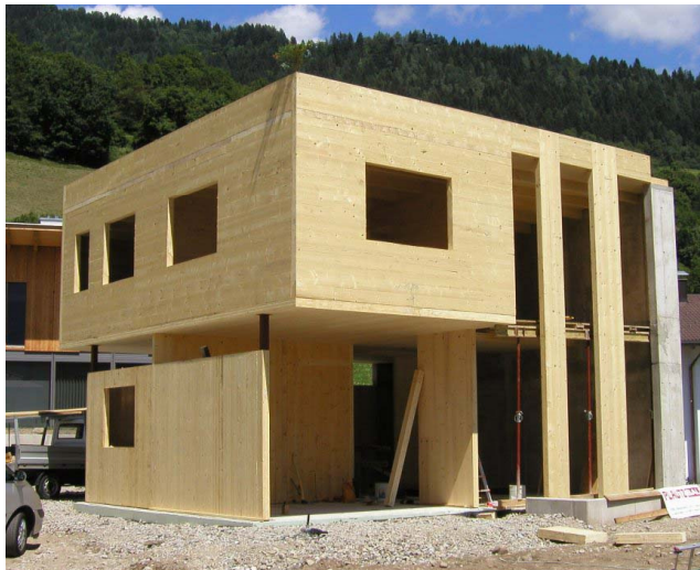
Struttura in pannelli xlam
