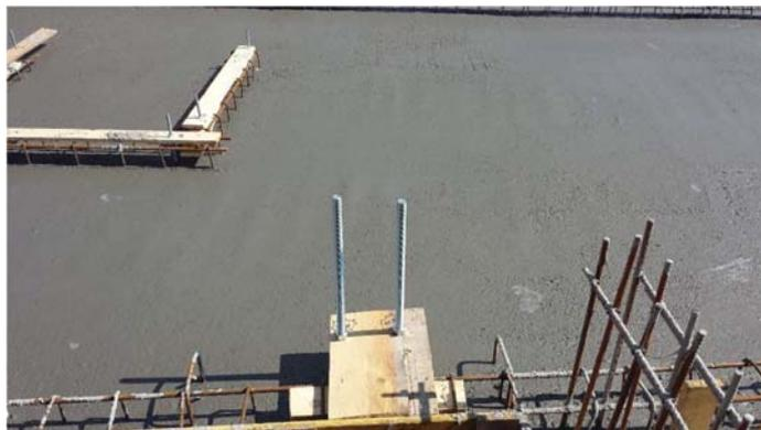
Le barre filettate necessarie per l'ancoraggio delle connessioni a trazione sono state poste in opera prima del getto del solaio in c.a.
