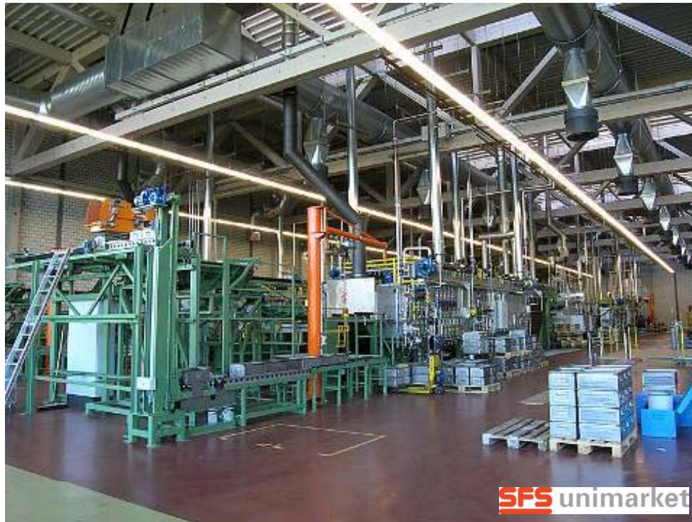
Travi di copertura in legno per una ottimale sicurezza in caso di incendio
