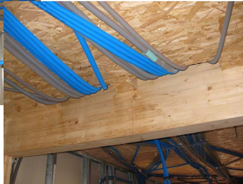
Inserimento di una trave nello spessore del solaio per permettere il passaggio degli impianti da un ambiente all'altro.
