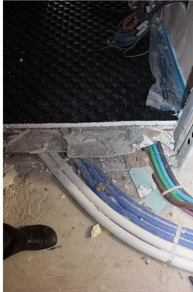
**Le componenti impiantistiche non devono interferire con la statica della struttura lignea**
