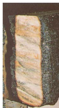
Figura 2: Trave di legno sottoposta ad incendio. Sotto lo strato carbonizzato il legno è ancora efficiente dal punto di vista meccanico.
