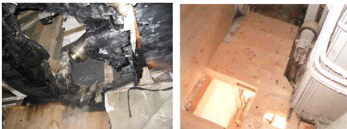
Figura 9. Strutture carbonizzate nel solaio del piano primo e consolidamento strutturale mediante la realizzazione di protesi incollate [13].
