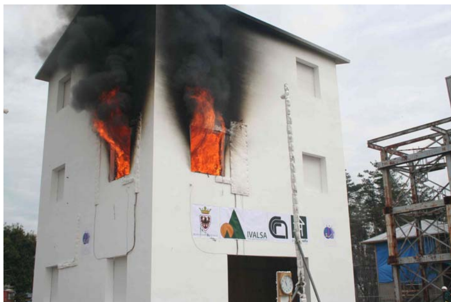
Figura 11: Un momento della prova durante la fase di incendio pienamente sviluppato (fonte www.progettotosofie.it ).
