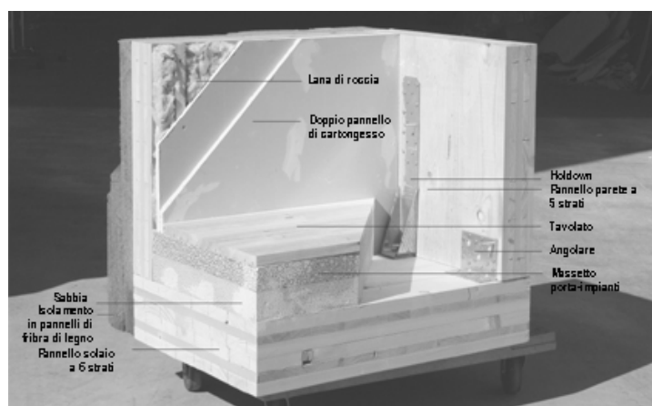
Figura 8: Pacchetti costruttivi per parete e solaio.
