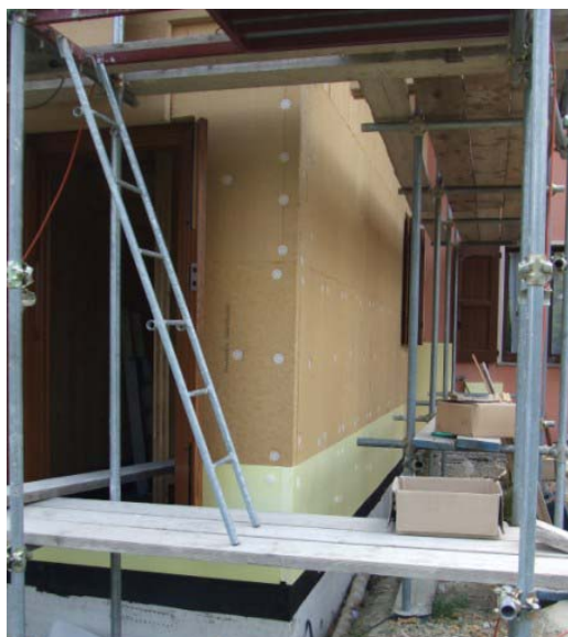
Figura 10: L'edificio, realizzato con struttura XLAM, è rivestito con pannelli di fibra di legno aderenti alla struttura; il successivo strato di intonaco rende la superficie non infiammabile e impedisce la propagazione del fuoco in facciata
