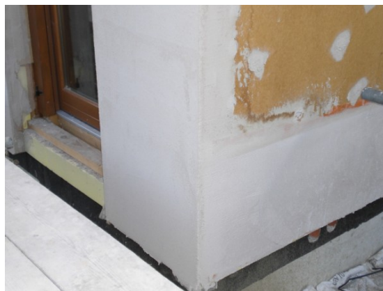
Figura 10: L'edificio, realizzato con struttura XLAM, è rivestito con pannelli di fibra di legno aderenti alla struttura; il successivo strato di intonaco rende la superficie non infiammabile e impedisce la propagazione del fuoco in facciata
