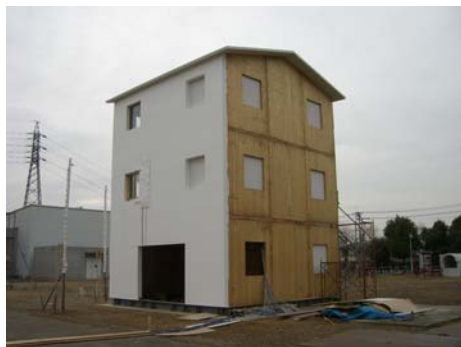
Figura 1: l'edificio SOFIE di 3 piani prima del test al fuoco (si noti la parte finita e la parte rimasta al grezzo).
