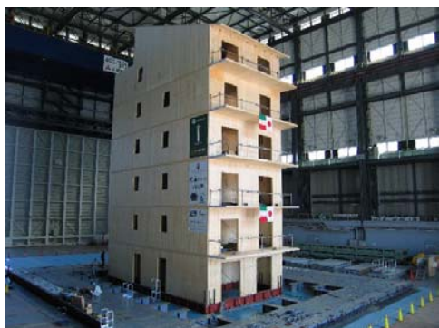
Figura 3: l'edificio SOFIE di 7 piani dopo tutti i test sismici
